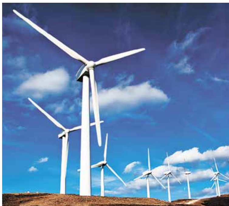
Scorcio di parco eolico in terra iberica.
